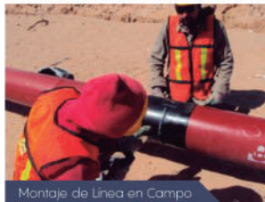
Montaje de Línea en Campo
